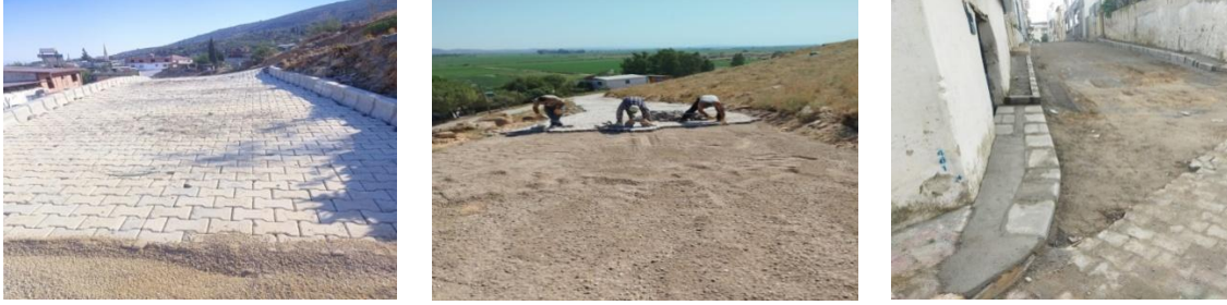
Kentin Muhtelif Yerlerinde Yapılan Yol Yapım Çalışmalarımız
