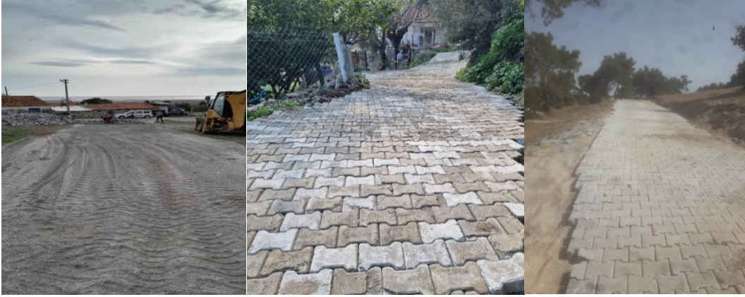
Kentin Muhtelif Yerlerinde Yapılan Yol Kaplama Çalışmalarımız
