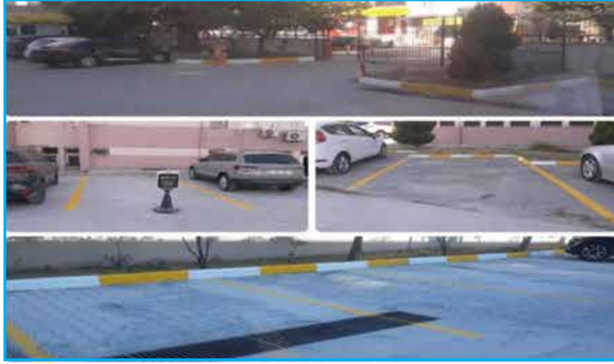
Adliye Binası Park Alanı Boyanması
