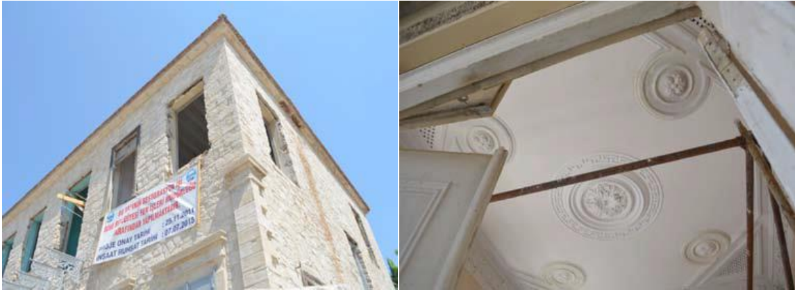
Söke Belediyesi Restorasyon Atölyesi Restorasyon Çalışması-Kemalpaşa Mah. Uzbek Konağı
