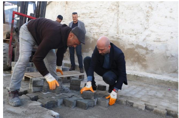
Yol yapım çalışmaları
